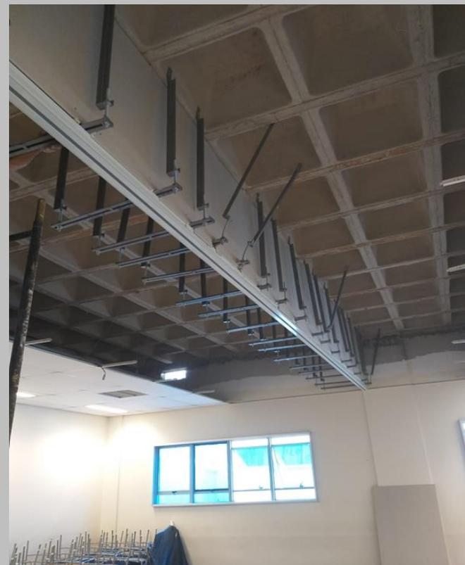
*Barreira Acústica - Elemento de extrema importância para o ambiente, evitando a passagem de som pela parte superior e inferior da divisória. O septo é formado por chapas de gesso acartonado c/ 12,5mm de espessura (podendo ser simples, duplo ou até triplo), miolo preenchido c/ manta de lã de rocha c/ densidade de 48kg/m<sup>3</sup>. Furos e frestas são devidamente calafetados.*
